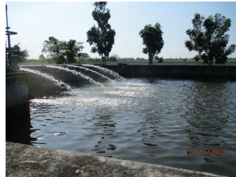
ภาพที่ 2-14 บ่อพักน้ำทิ้งของโรงไฟฟ้า
