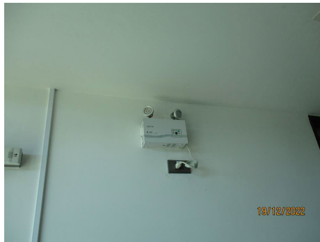
ภาพที่ 2-38 ระบบไฟฟ้าสำรอง
