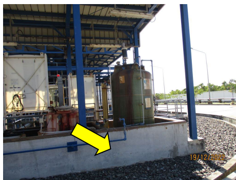
ภาพที่ 2-55 คันกัน (Dike) บริเวณสถานที่เก็บสารเคมี
